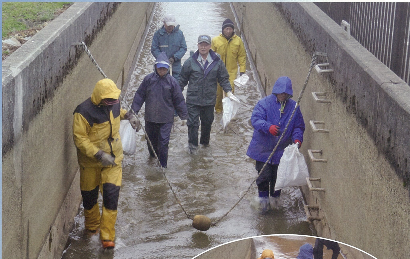
組合員による水路清掃（水田幹線用水路）
